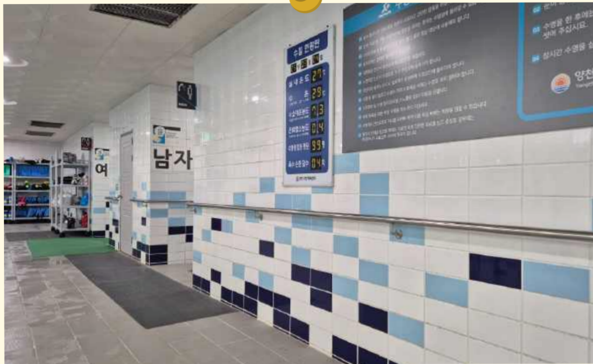
낙상사고 방지 안전손잡이 설치!
